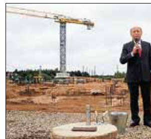
● Андрюс Кубилиус открывает строительство школы в Вильнюсе. В фундаменте школы — капсула с письмом для будущих поколений. ФОТО: VZ.LT
