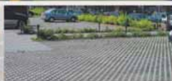
ГАЗОННЫЕ РЕШЕТКИ Основное назначение — укрепление газона или откосов (через пустоты решетки осуществляется дренаж). Также используются для создания автоотстойков.
