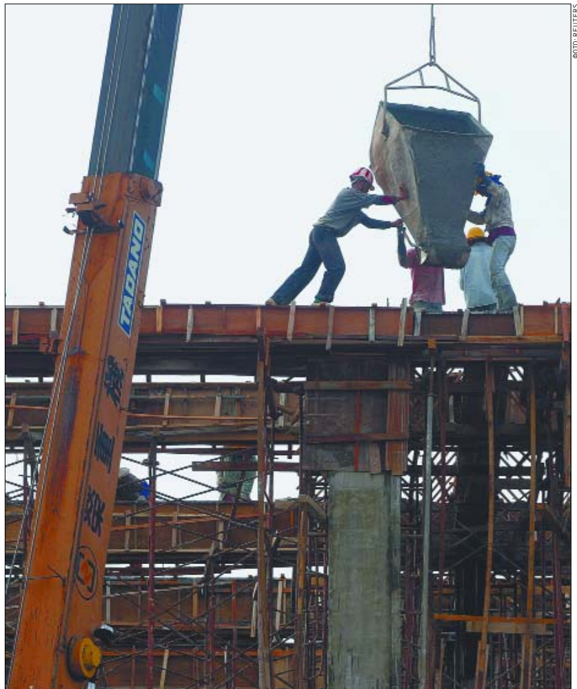
Петербургские домостроители перенимают опыт соседней Финляндии, где каркасное домостроение широко применяется при возведении многоэтажных домов.
